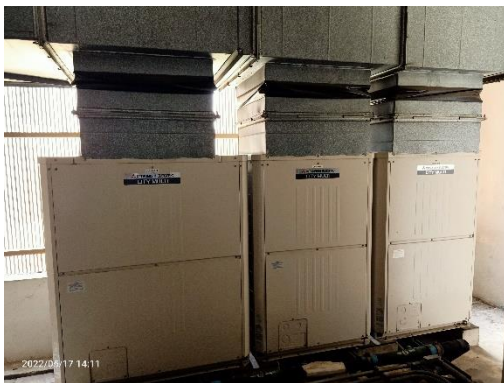
เครื่องปรับอากาศแบบ VRF ประจำชั้น 5 และ ชั้น 8-31
