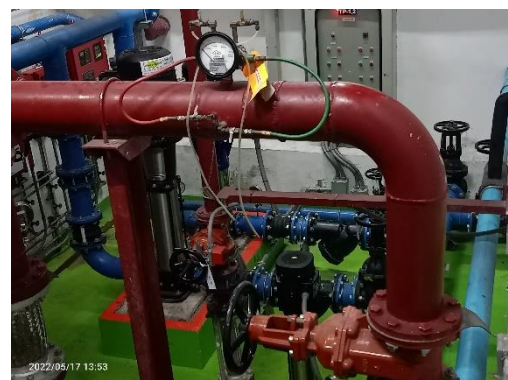
ปั๊มสูบน้ำ ขึ้นไปยังถังเก็บน้ำชั้นหลังคา
