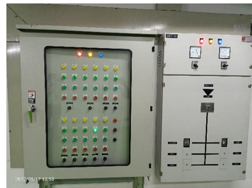
ตู้ควบคุมการทำงานระบบบำบัดน้ำเสีย
