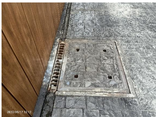
บ่อ Man Hold ที่ใช้เป็นระบบบ่อหน่วงน้ำ ภายในโครงการ
