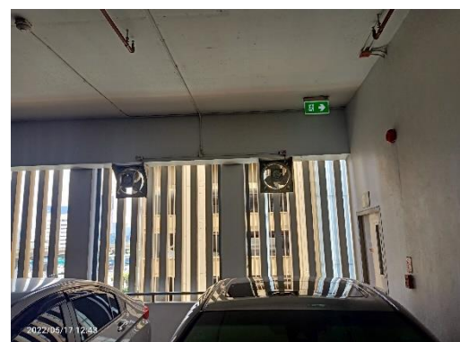
ช่องเปิด และพัดลมระบายอากาศ ที่อาคารจอดรถ
